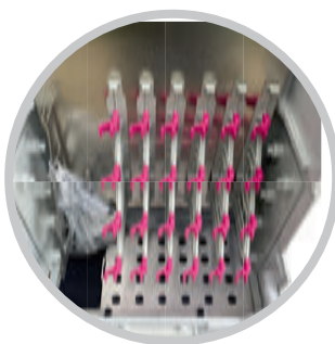
Prawa strona - Wprowadzenie mikrorur Lewa strona - Wprowadzenie kabli światłowodowych/mikrorur Uchwyty na mikrorury
