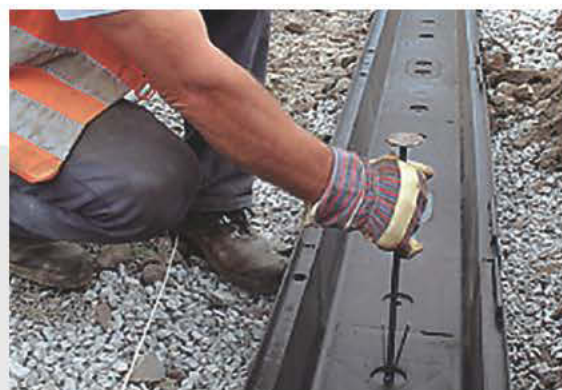
Przytwierdzenie kanałów do podłoża przy pomocy specjalnych szpilek do kotwienia
