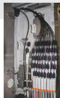
Tylna płaszczyzna pracy ze specjalnym systemem ułożenia mikrorur
