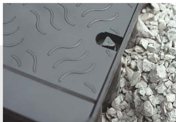
Wypełnienie terenu wokół kanałów kablowych
