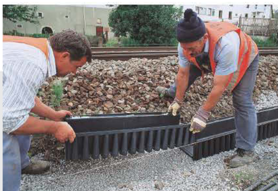
Ułożenie kanałów na wyznaczonej trasie
