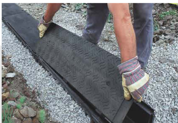
Montaż pokryw
