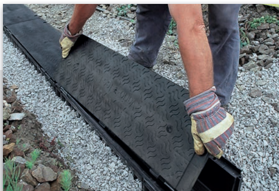
Montaż pokryw
