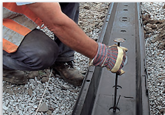
Przytwierdzenie kanałów do podłoża przy pomocy specjalnych szpilek do kotwiczenia
