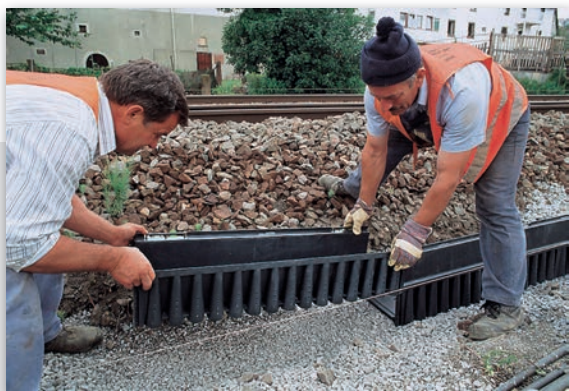
Ułożenie kanałów na wyznaczonej trasie
